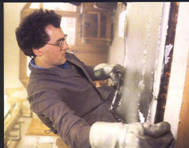
Beim „Ausdünnen“ wird die verbliebene Plattenstärke kontrolliert.
