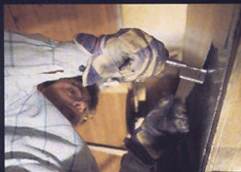
Beim „Ausdünnen“ wird die verbliebene Plattenstärke kontrolliert.
